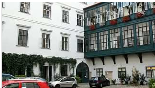
Großer Gebäudekomplex in einem der ältesten Viertel Wiens.
